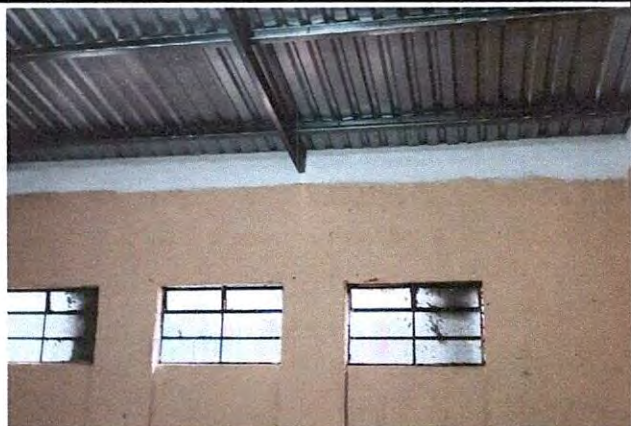
Foto 3: Se cerró en la parte superior con bloques y repello para su mejor presentación.
