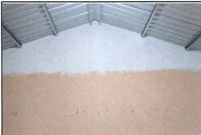
Foto 4: Se cerró con bloques y repelló para su mejor presentación del aula ya que hubo remanente.
