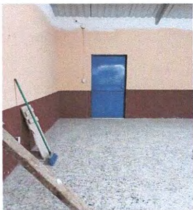
Foto1: Visualización del cerramiento en la parte superior del aula y colocación de piso de granito.
