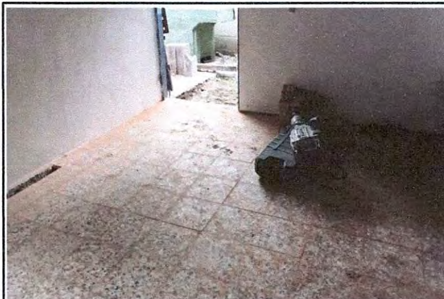
Foto 4: Finalización de colocación de piso.
