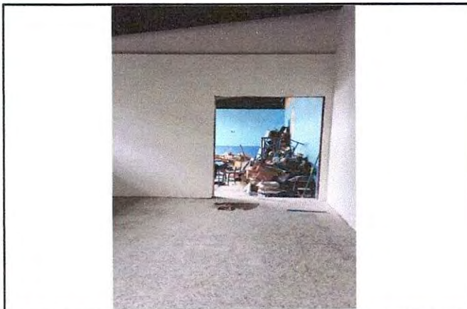
Foto 4: Finalización de colocación de piso de granito y pintado de puerta de metal.
