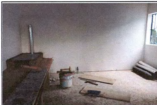
Foto 3: Colocación de chimenea y piso de granito.
