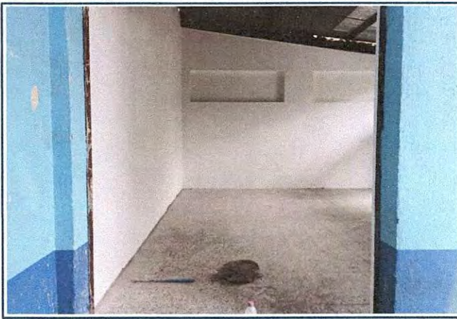
Foto 2: Limpieza de restos de cemento por la colocación de piso en bodega.
