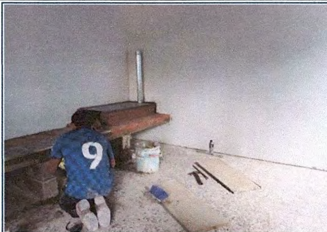
Foto 2: Trabajos de mejoramiento en cocina.
